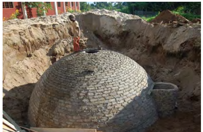
2 Im September war die Anlage fertig.
