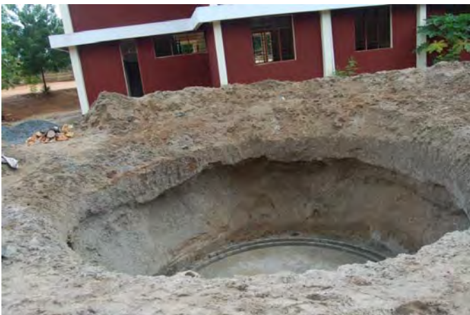
1 Der Bau der Biogasanlage begann im Februar
